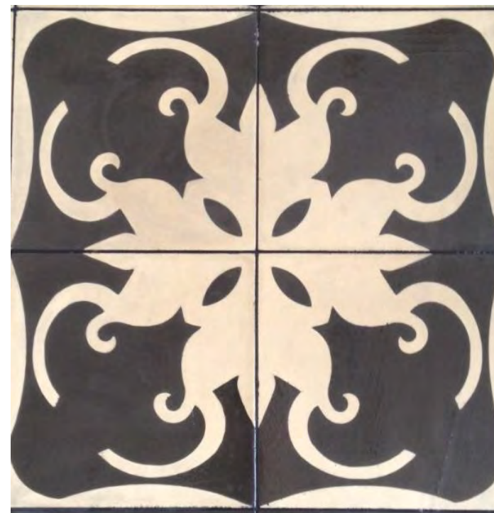
Zementfliesen gut verfugt und gereinigt
